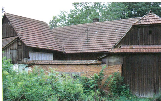
Stav před zbouráním
