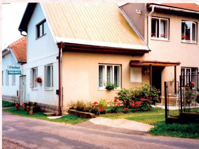
současný stav po přestavbě stodoly r.1961, nové čp. 552
